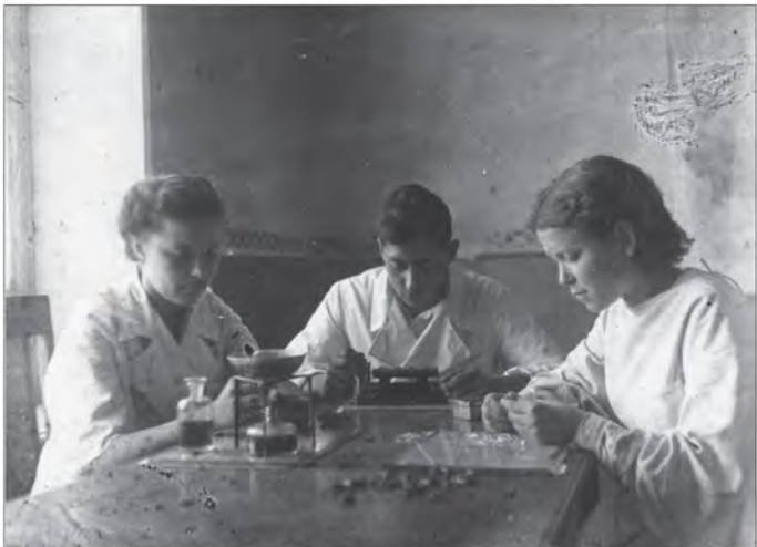
Обработка (проверка) минометных уровней. Ликеро-водочный завод. Спецлаборатория. 1943 г.
