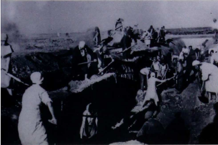
Сталинградские трудящиеся на строительстве оборонительных сооружений. Г. Сталинград. 1942 г.
