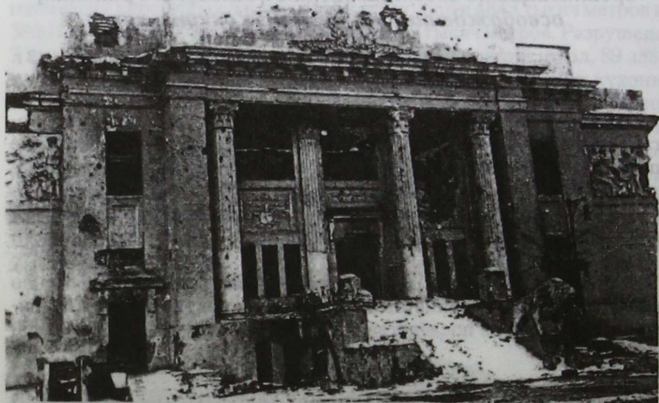
Разрушенное здание драматического театра в Сталинграде. 1947 г.
