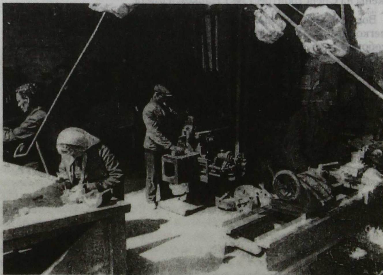
Разрушенный цех одного из заводов Сталинграда, в котором продолжалась работа.
