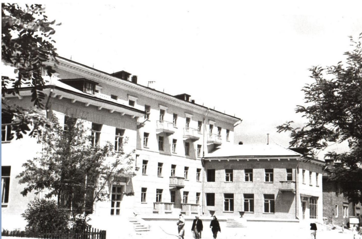
Восстановленные жилые дома Тракторозаводского района, г. Сталинград. 1950 г. / ЦДНИВО. Ф. 13226. Оп. 1. Д. 2931. Л. 4.
