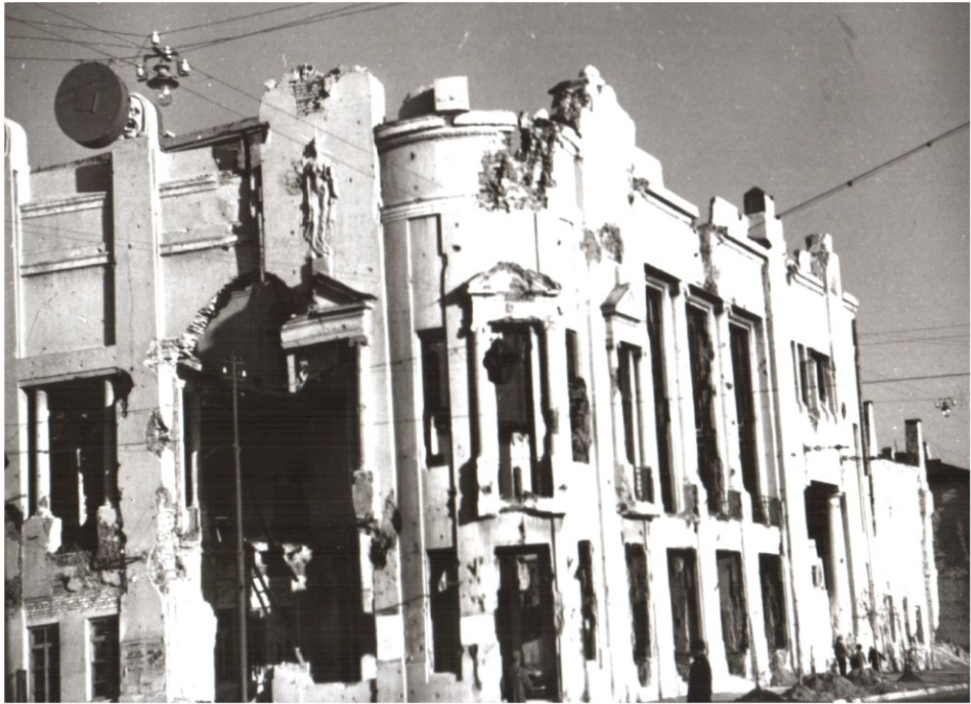
Разрушенный Театр юных зрителей Сталинград, 1943 г. / ЦДНИВО. Ф. 13226. Оп. 1. Д. 2922. Л. 1.
