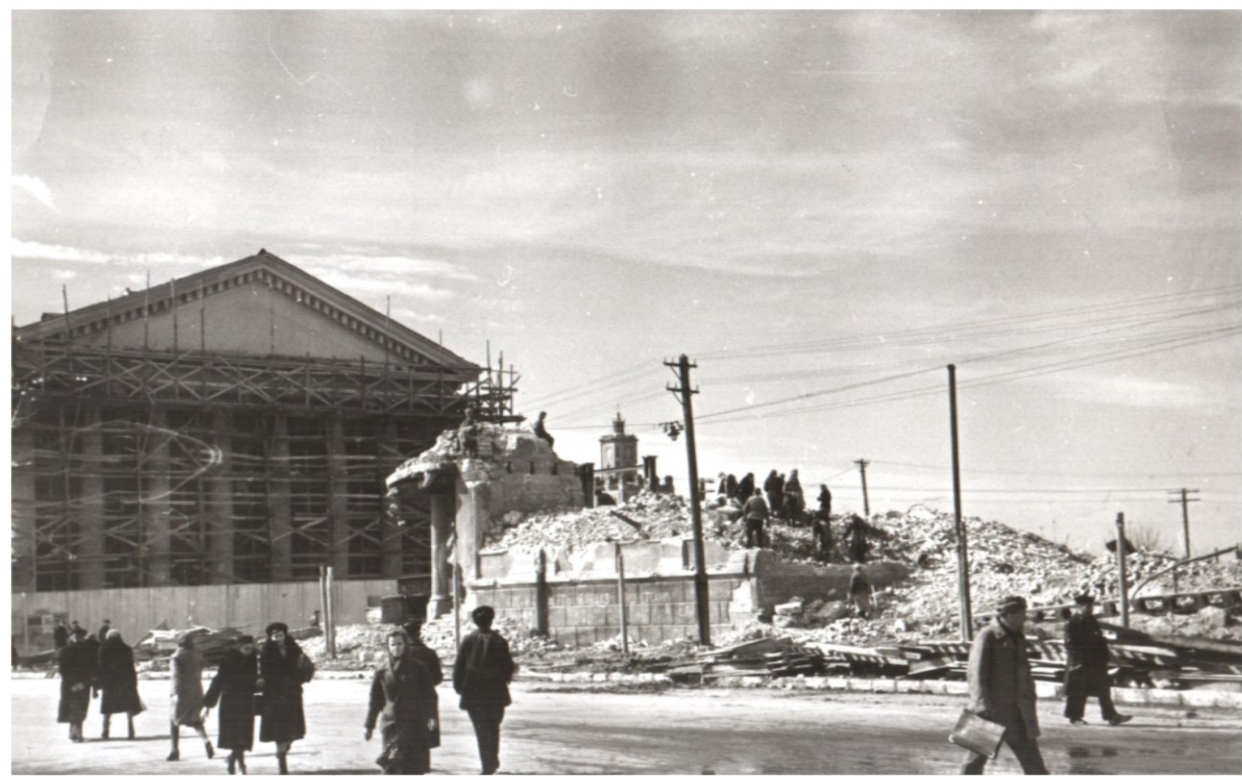
Восстановление драматического театра им. Горького в послевоенном Сталинграде. 1950 г. / ЦДНОВО Ф. 13226. Оп. 1. Д. 2928. Л. 1.
